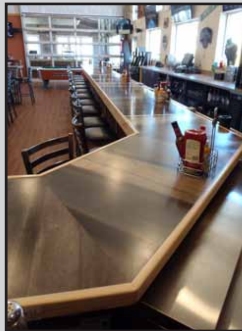
Main Bar Barn Wood Inset Ash Hardwood Trim Epoxy Pour Top Coat
